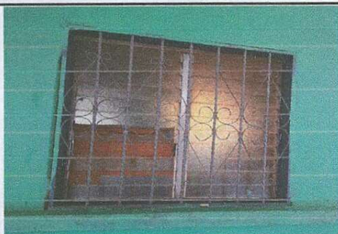
Foto 5: Sustrucción de ventanas de metal por PVC
