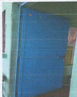
Foto 4: Sustrucción de pintura de puerta salón tres
