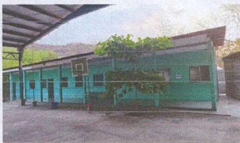
Foto 3: Sustrucción de pintura interior y exterior 3 aulas y corredor
